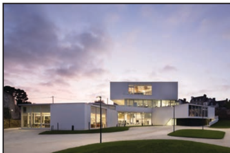
Médiathèque municipale de Baud
