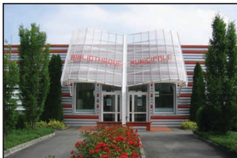
Médiathèque François Mitterrand
