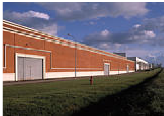
Façade de l'atelier de montage
