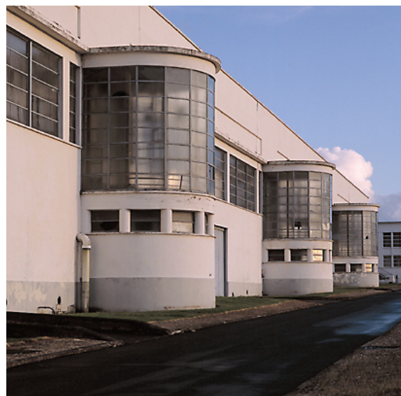
Façade de l'atelier des pièces détachées
