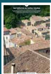
05 les toitures en tuiles rondes
