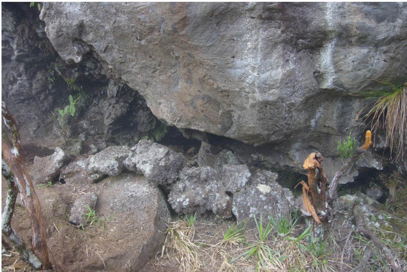
[Fig. 20c] : Vue du muret dans la partie ouest
