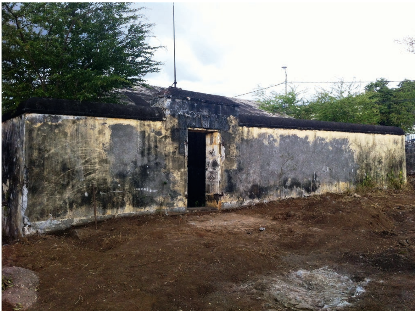
[Fig. 18i] : Vue des abords de la Poudrière et des structures mises au jour en fin de sondages
