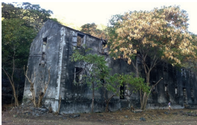
[Fig. 6d]: Vue extérieure du dortoir/réfectoire
