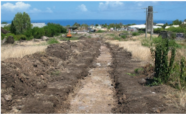
[Fig. 14b] : Diagnostic vu depuis l'est
