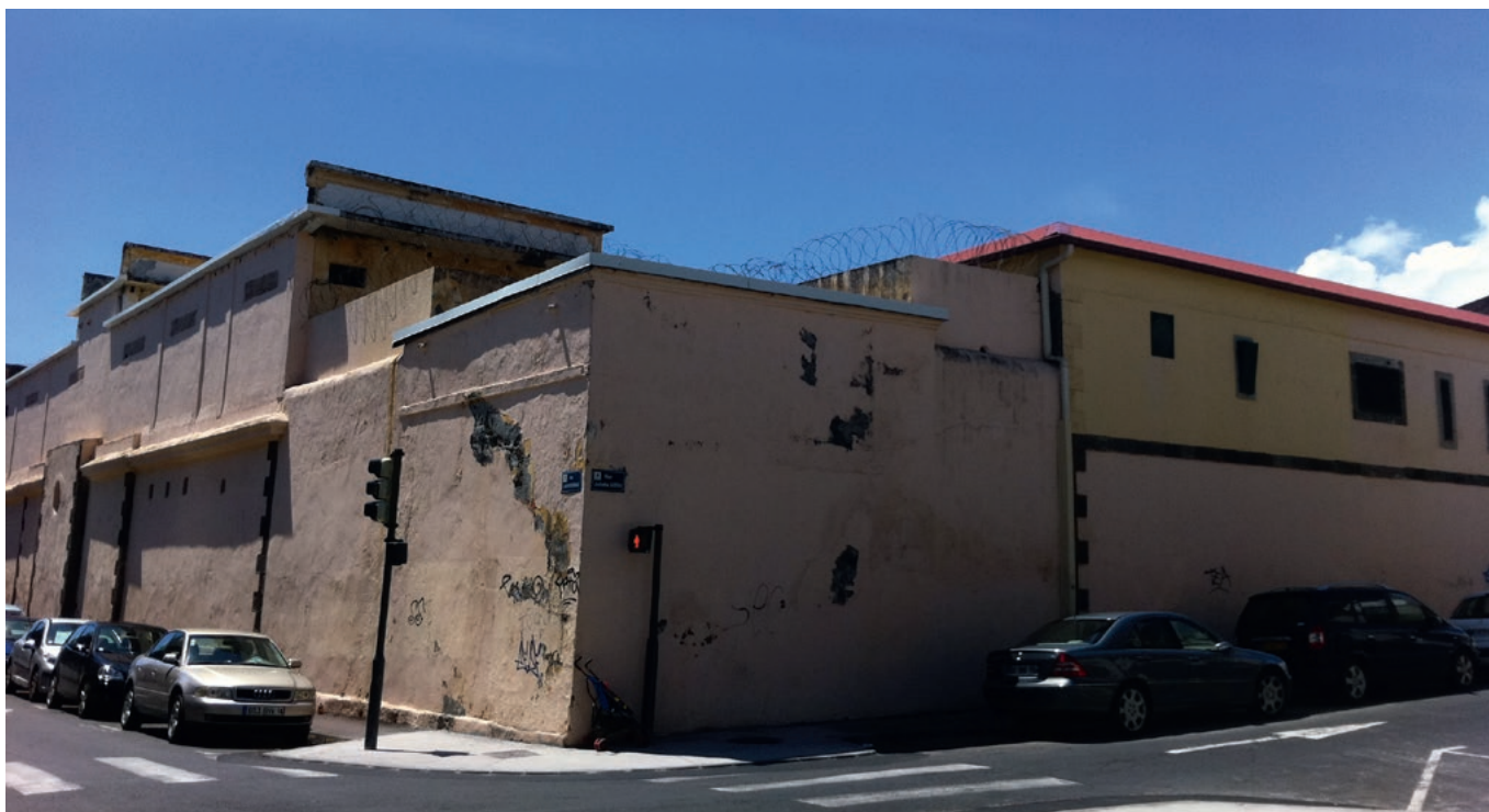
[Fig. 23a] : Vue extérieure de l'enceinte de la prison et du bâtiment du 18 e siècle à l'angle des rues Labordonnais et Juliette Dodu
