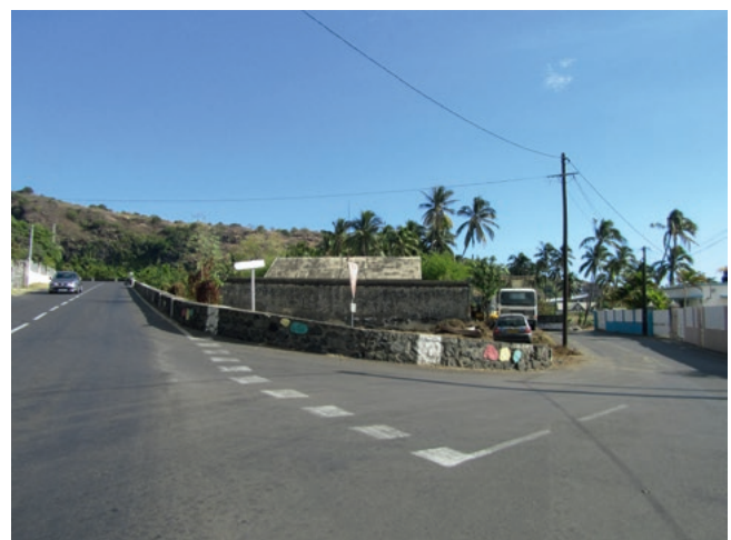
[Fig. 18a] : Vue extérieure du site de la Poudrière
