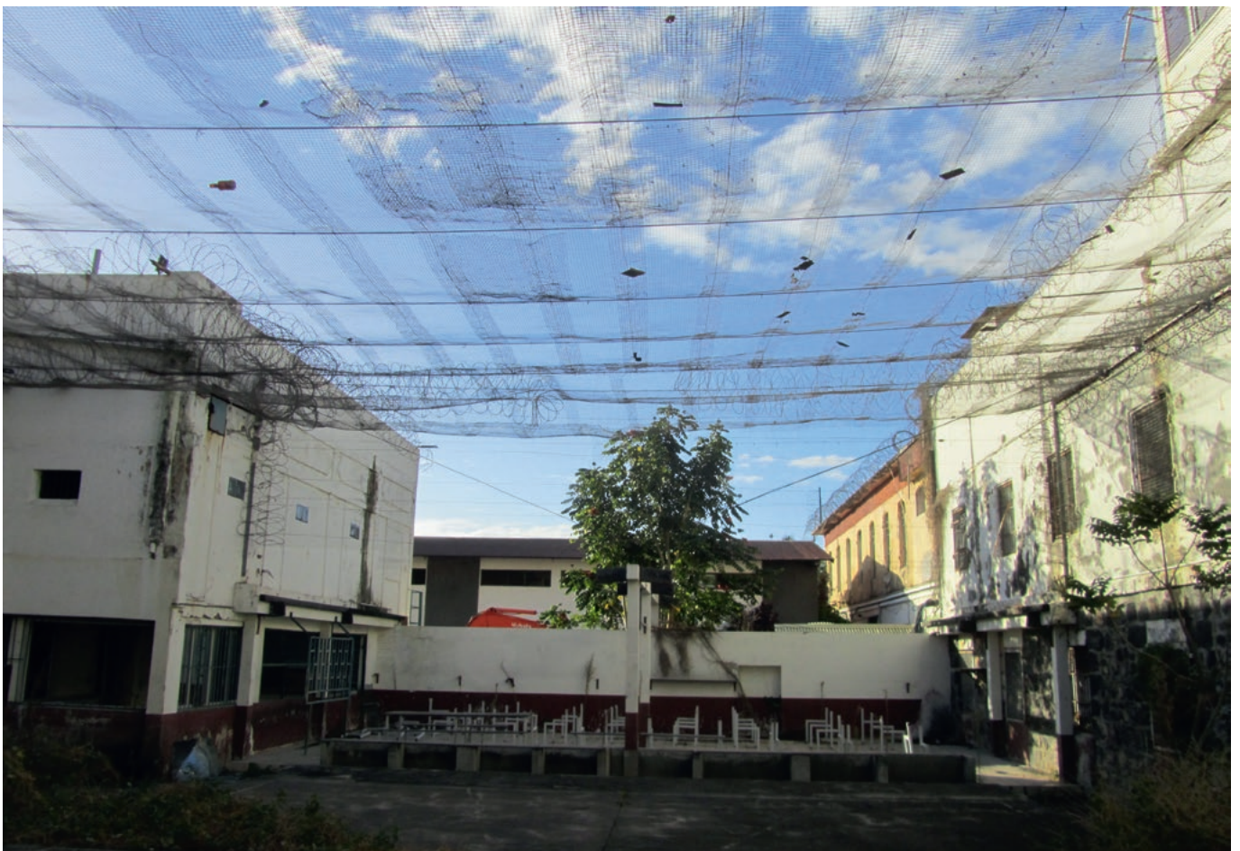
[Fig. 23d] : Vue depuis la cour sud de la prison
