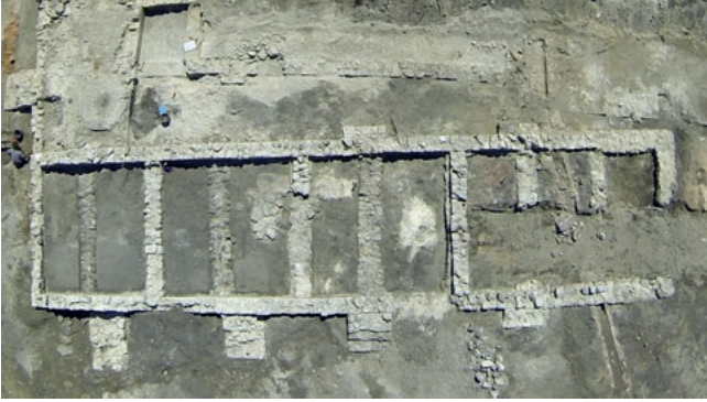
[Fig. 15e] : Vue aérienne du bâtiment BAT 112
