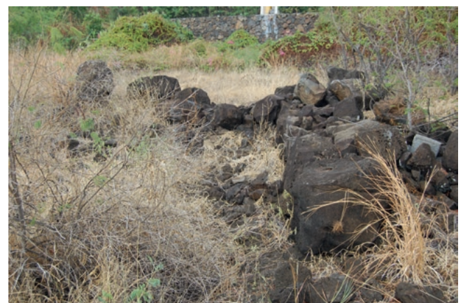
[Fig. 33d] : Vue d'un vestige de mur maçonné sur le site du camp dit «des engagés»
