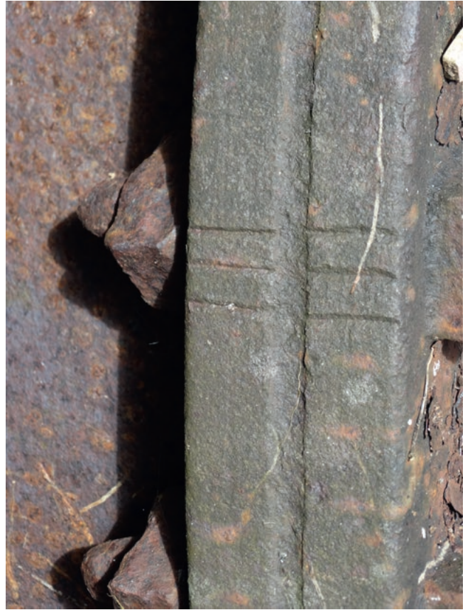
[Fig. 34c] : Repères d'assemblages des fûts de la chaudière
