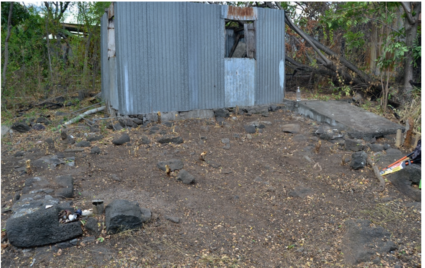
[Fig. 16b] : Vue de la structure en début de décapage
