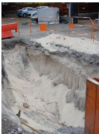
[Fig. 27b] : Vue de la tranchée de pose de la canalisation aux Roches Noires
