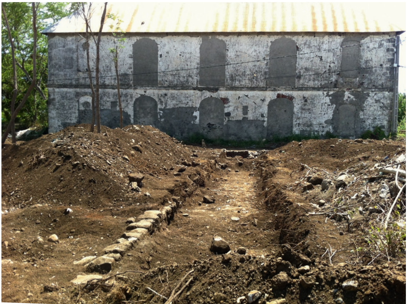
[Fig. 13g]: Structure St 7, interprétée comme un allée monumentale à l'arrière de la Grande Maison
