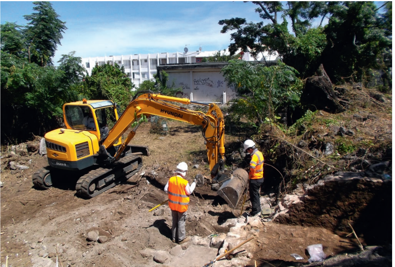
[Fig. 37f] : Diagnostic de la terrasse inférieure et du bâtiment en ruines
