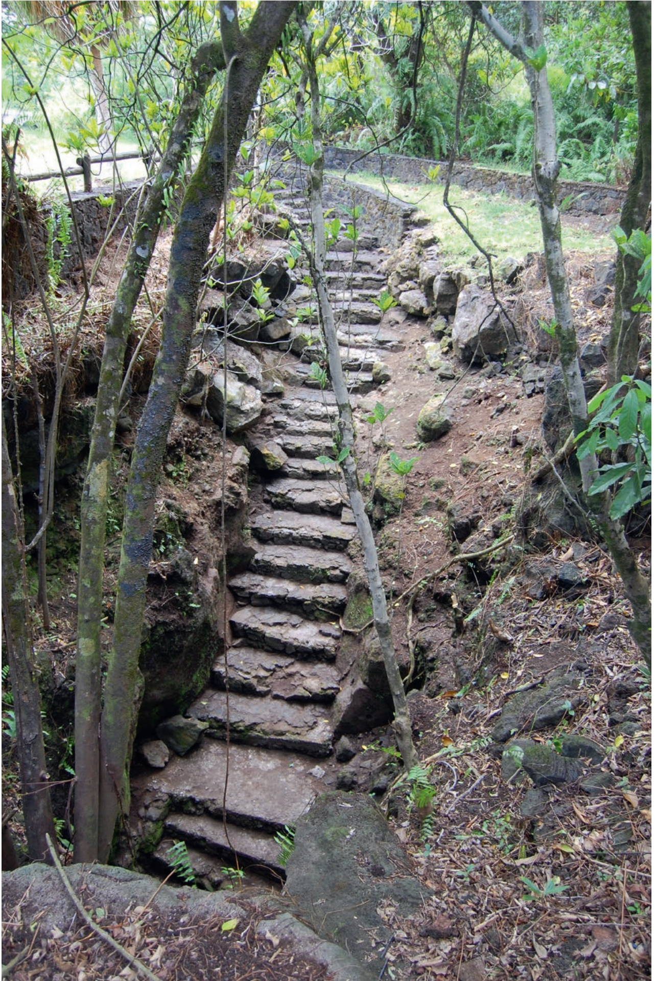
[Fig. 29k]: Vue de la rampe latérale de l'extérieur
