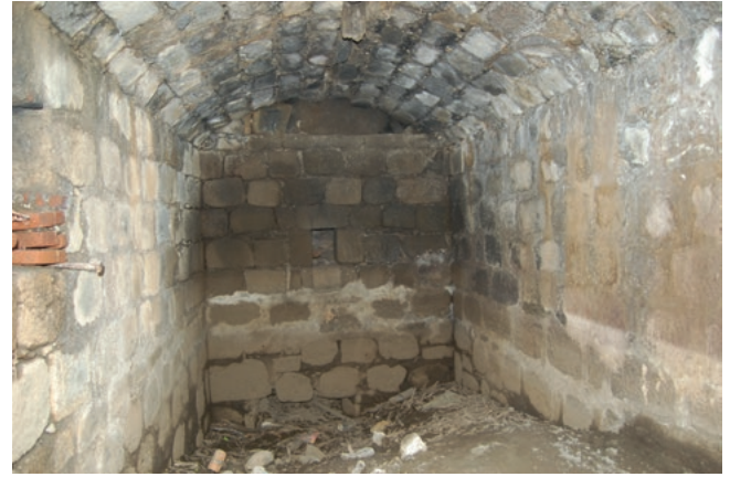
[Fig. 19d]: Vue de l'extrémité nord
