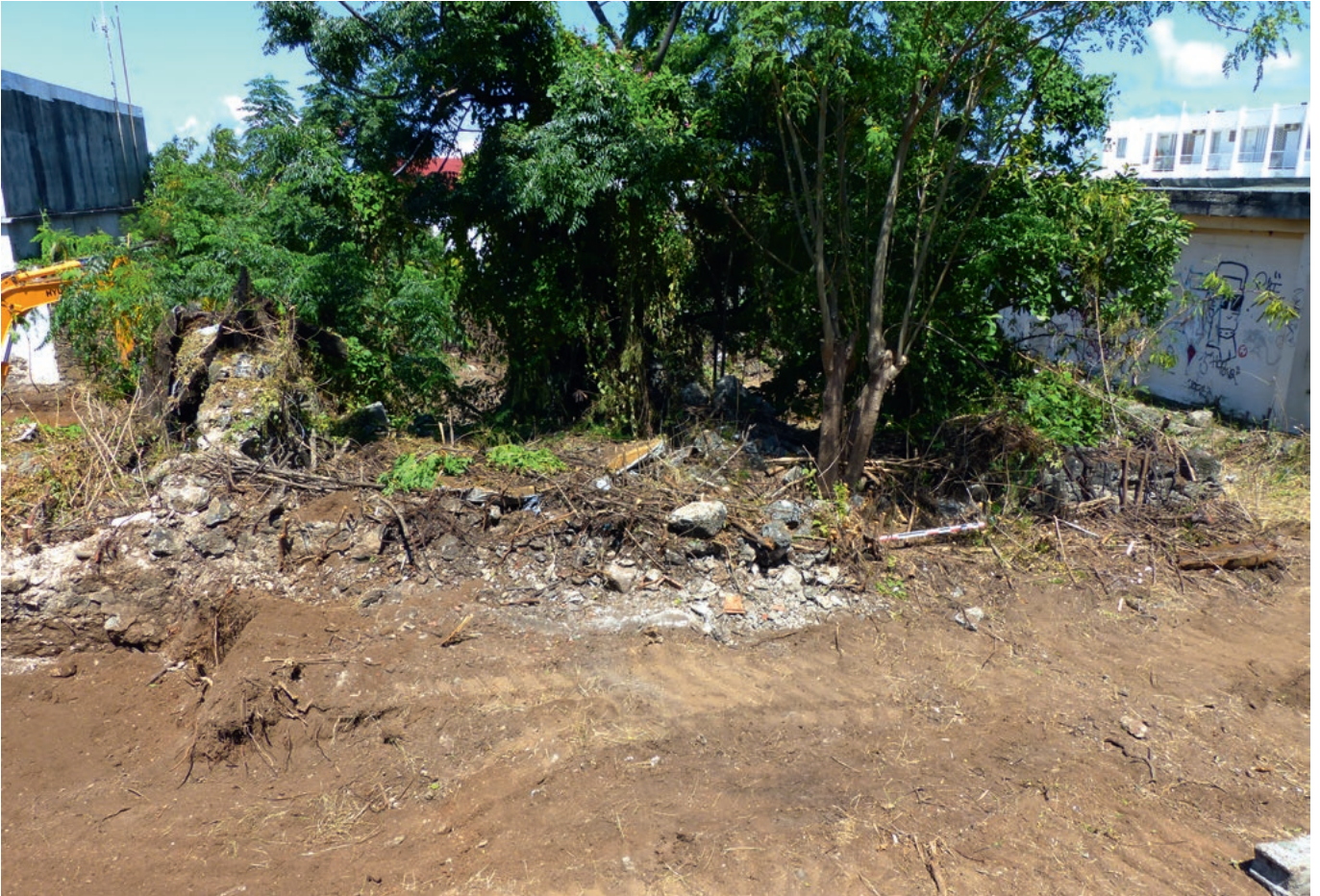
[Fig. 37e] : Vue du bâtiment en ruines de l'entrepôt de la terrasse supérieure
