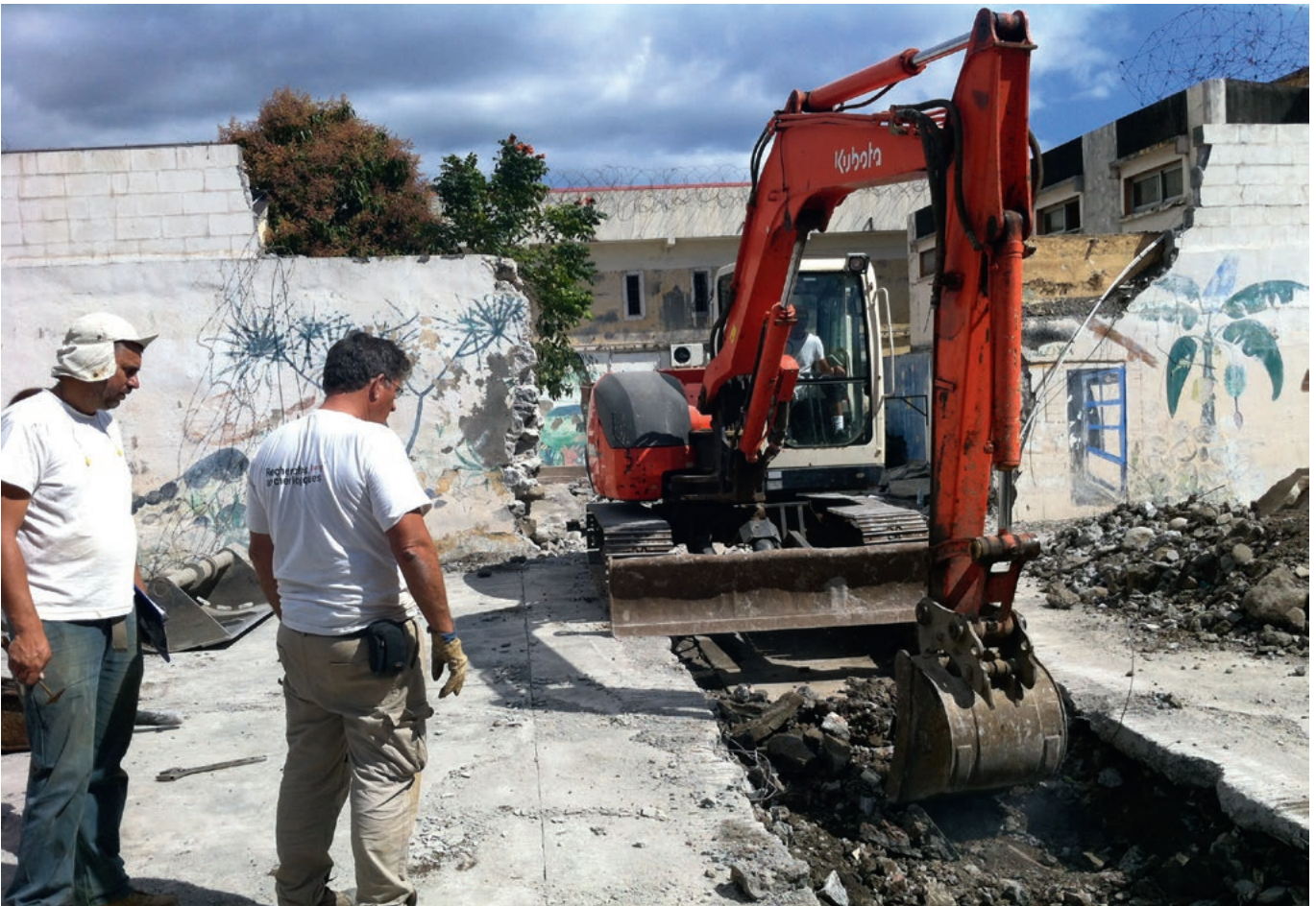
[Fig.23h] : Ouverture du diagnostic entre les cours nord
