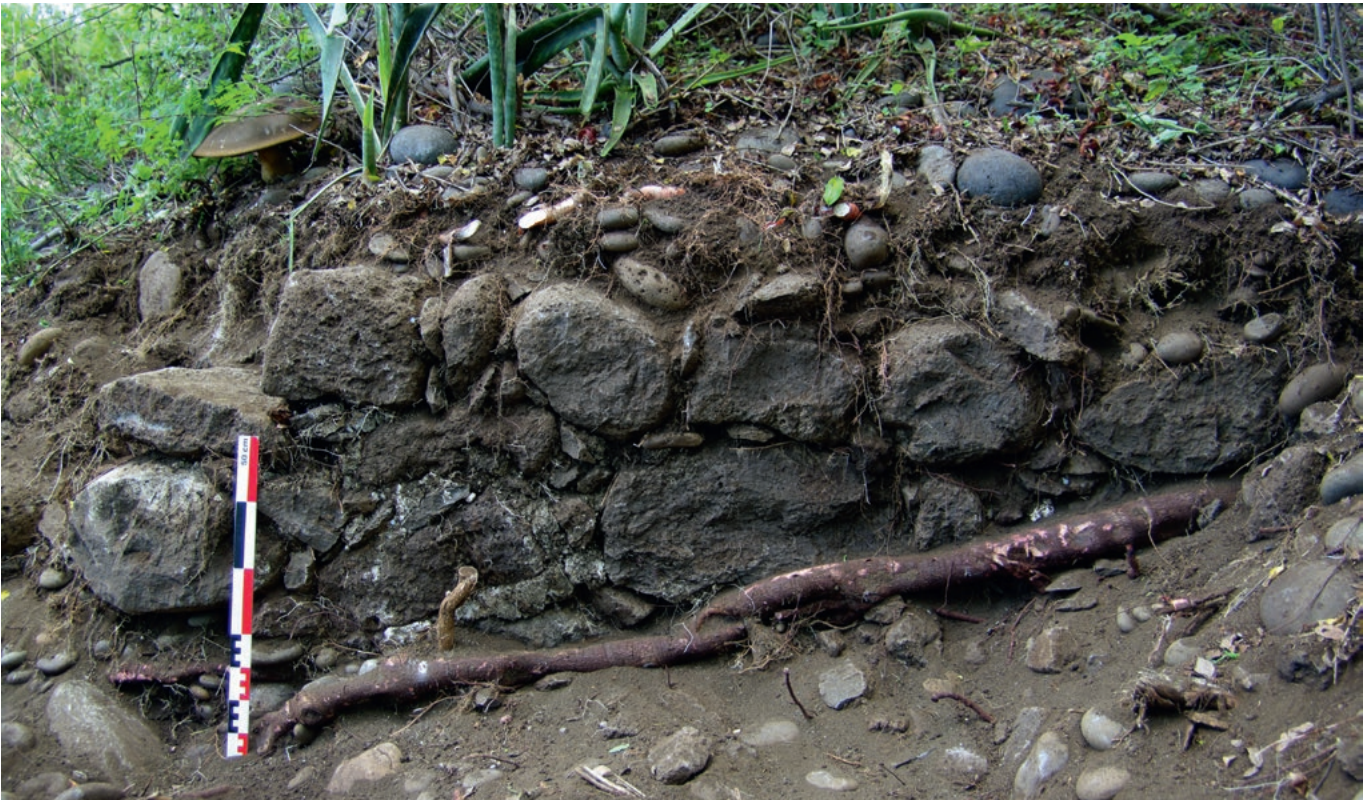
[Fig. 10i]: Vue de l'extrémité nord du mur nord-sud des vestiges en élévation
