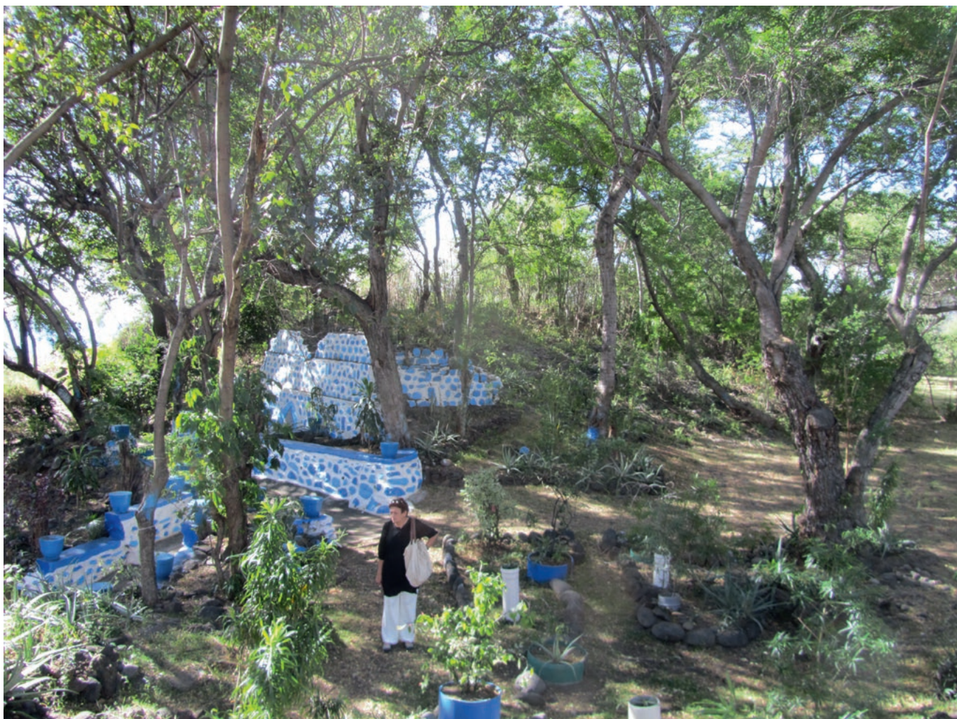
[Fig. 10c] : Vues des vestiges de la batterie n°1 en élévation en 2012
