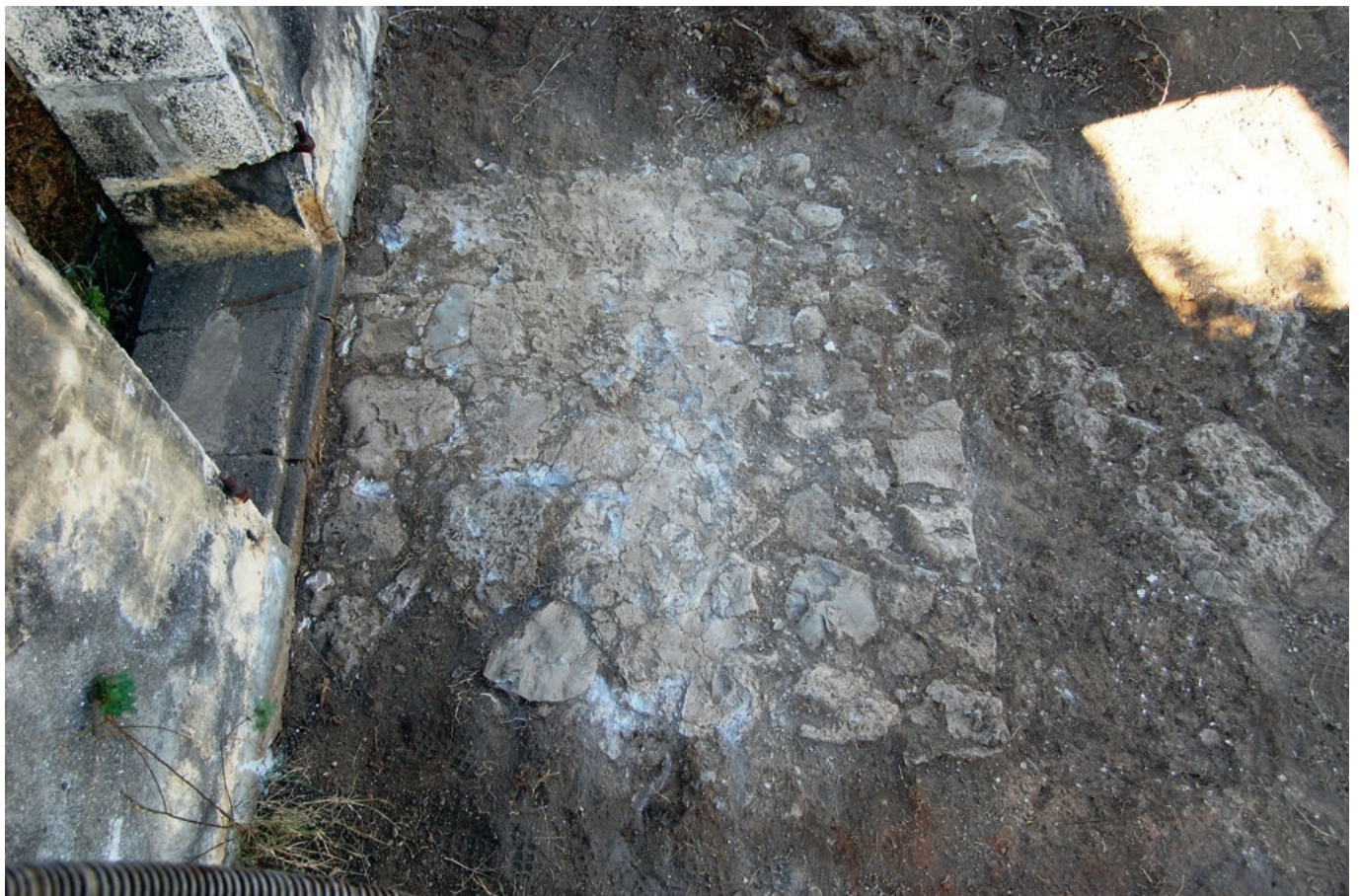
[Fig. 18d] : Vue du dallage au seuil de l'entrée
