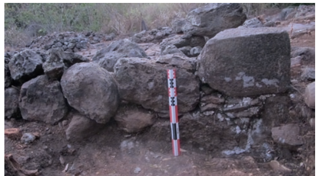
[Fig. 26g] : Vue latérale de l'angle nord-est
