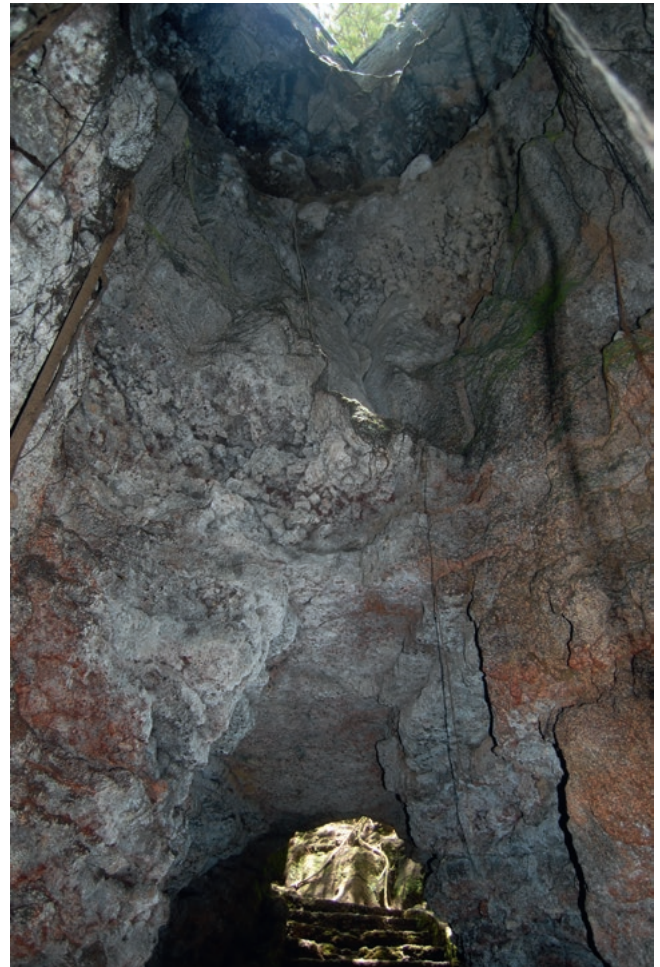
[Fig. 29j]: Vue du conduit vertical de l'intérieur
