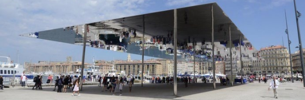
Ombrière du Vieux-Port - Marseille
