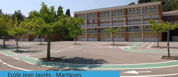
Ecole Jean Jaurès - Martigues
