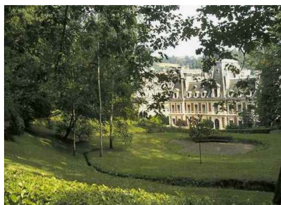
Parc de la Préfecture à Tulle © Préfecture de la Corrèze
