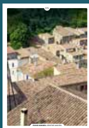
05 les toitures en tuiles rondes
