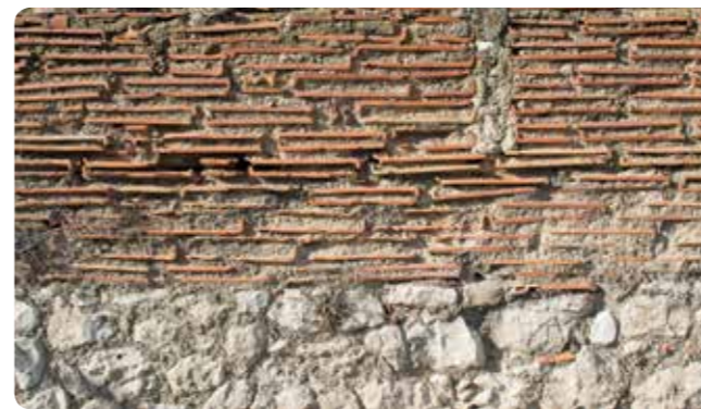
Mur de clôture réalisé en tuiles hourdées au mortier Marseille, quartier Saint-Henri
