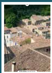
05 les toitures en tuiles rondes
