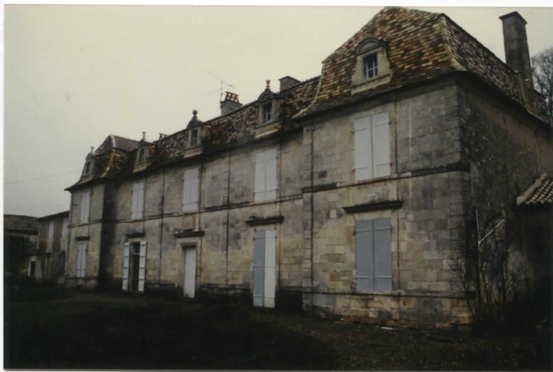
Elevation Nord du logis -
