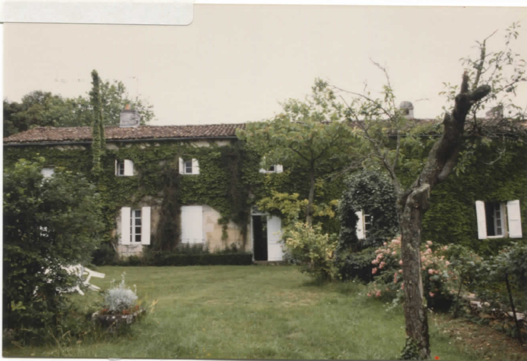
Élévation nord du logis.
