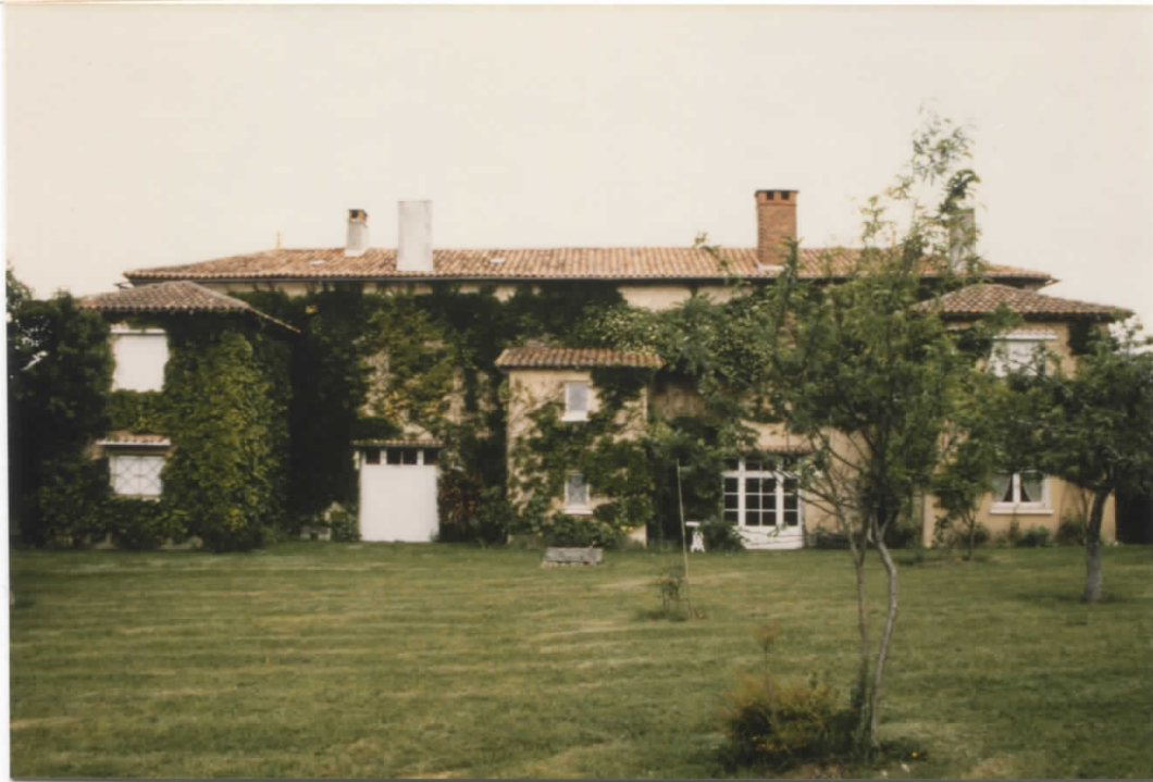
Logis - Façade postérieure -
