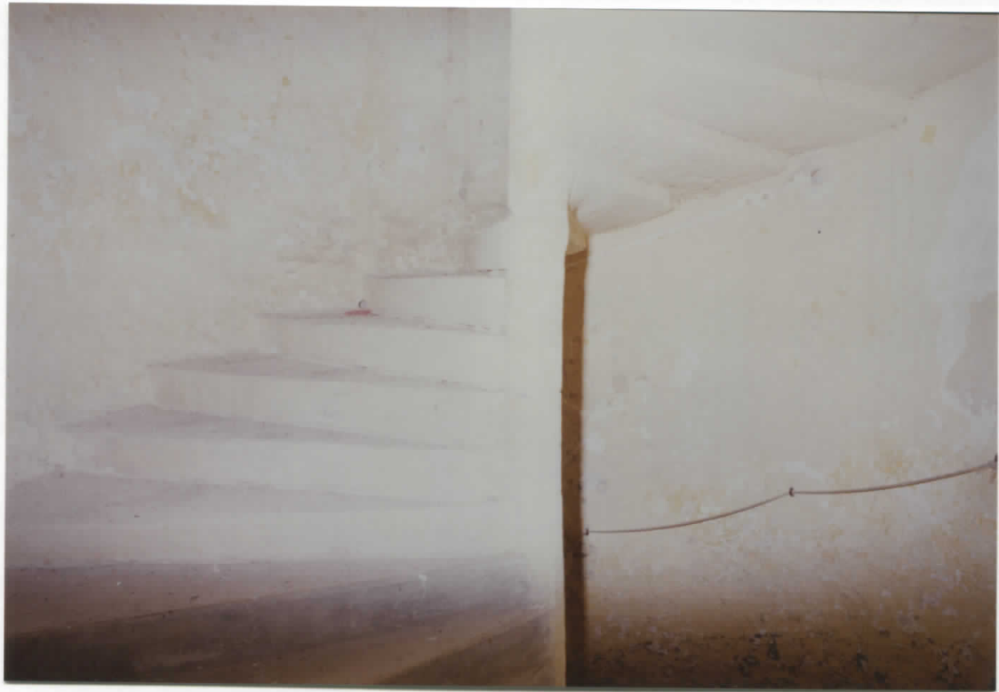
Escalier en vis de la tour carrée en avancée sur la cour -
