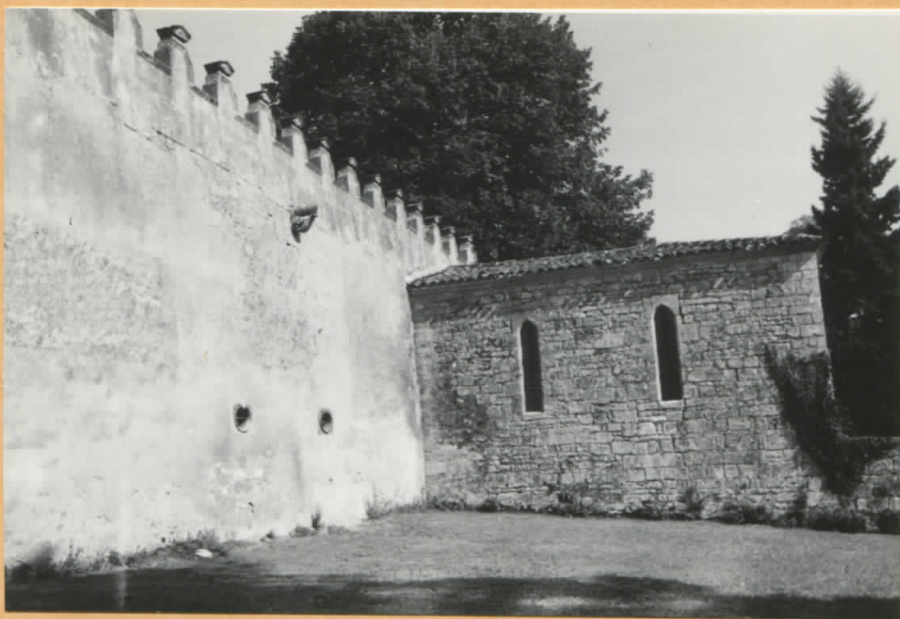
Chapelle accolée au mur de façade du logis (dernière siècle)
