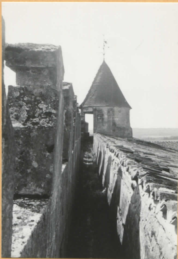
Tourelle d'escalier conduisant le long des créneaux
