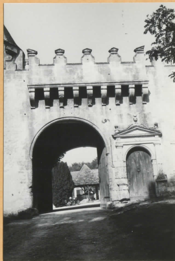
Portail d'entrée (porte et poterne) défendue de neuf mâchicoulis
