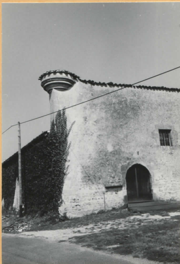
Base d'une ancienne tourelle d'angle en encorbellement
