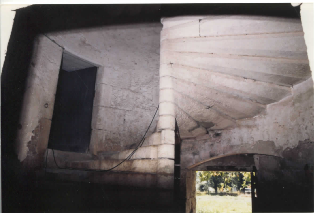
cage d'escalier en vis dans pavillon S.O
