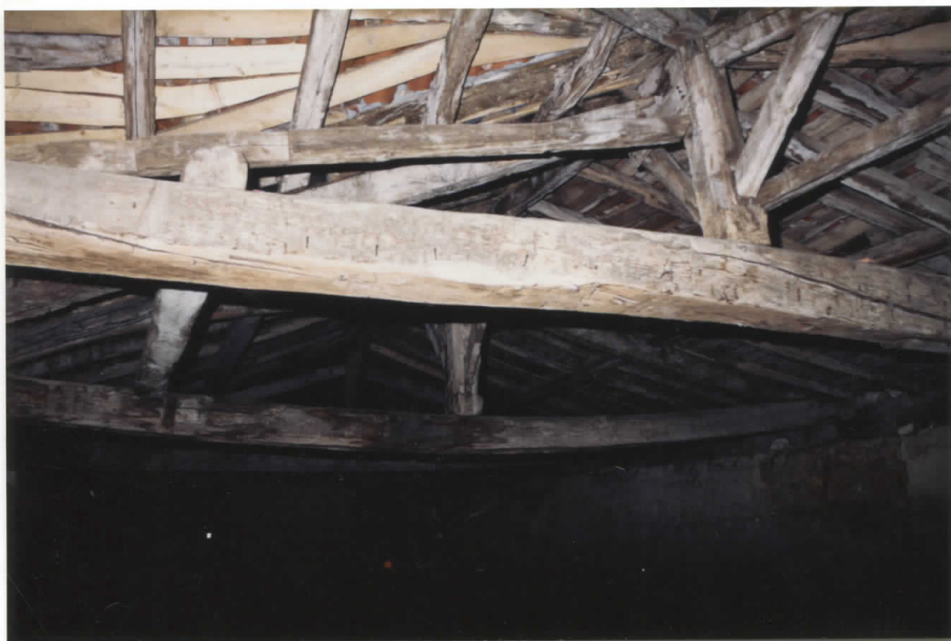
Charpente du bâtiment S.O
