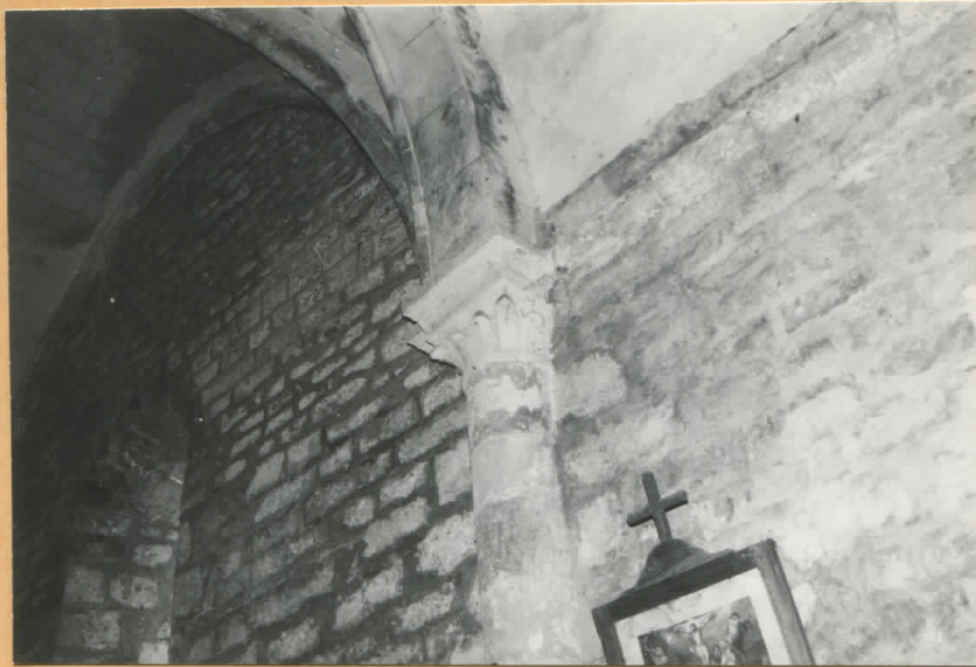
Chapiteau à feuillages recevant la retombée du grand arc brisé séparant le sanctuaire de la nef
