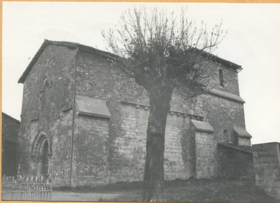
Vue latérale Sud
