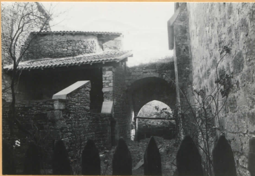
Vue latérale Nord donnant sur des restes de bâtiments religieux
