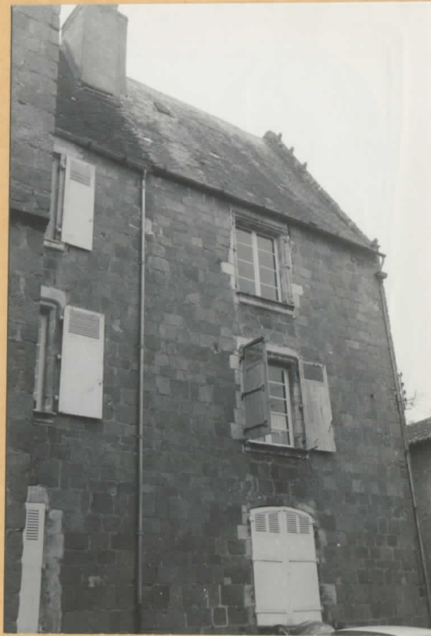
Corps de logis recouvert d'une toiture à deux pans aux rampants ornés de crochets
