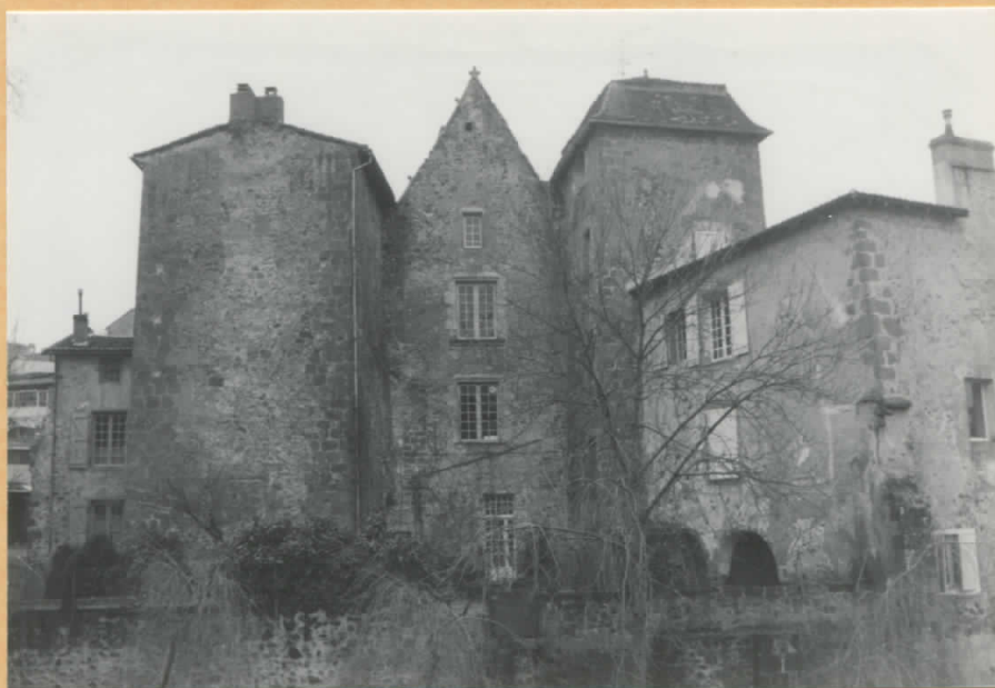
Vue d'ensemble des quatre corps de logis du manoir
