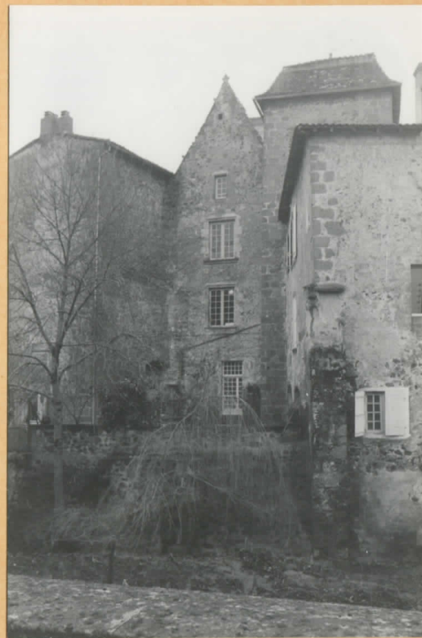
Façades sur le Goire
