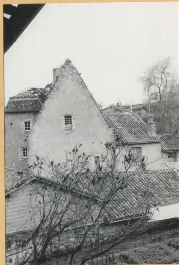
Le manoir et ses toitures vues des hauteurs de Confolens
