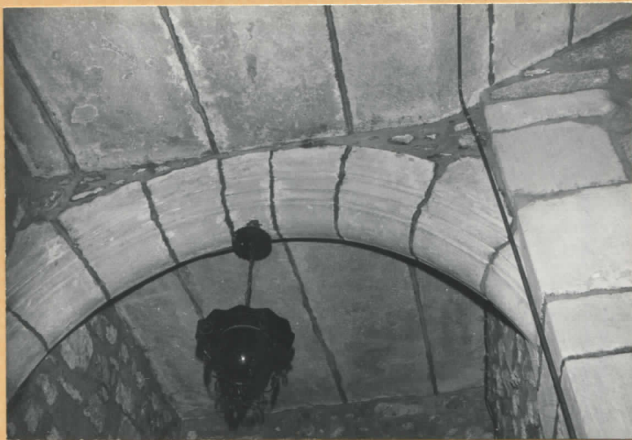
Arcade de l'escalier intérieur accessible par la porte Renaissance
