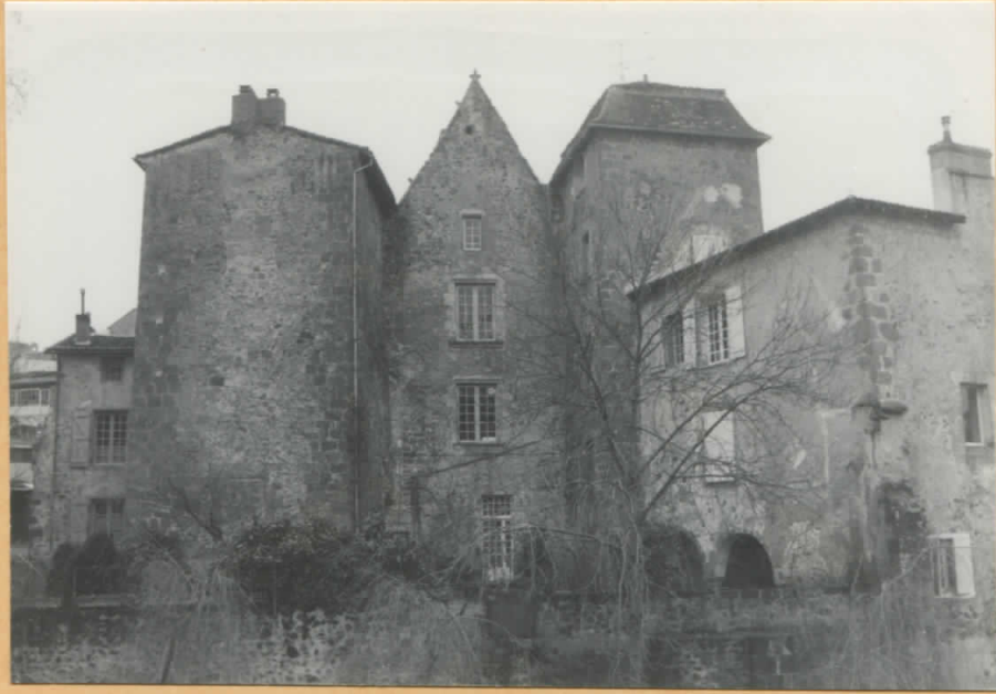
Vue d'ensemble des quatre corps de logis
