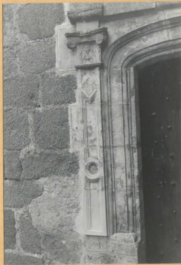
Détail d'un pilastre et de son chapiteau à volutes
