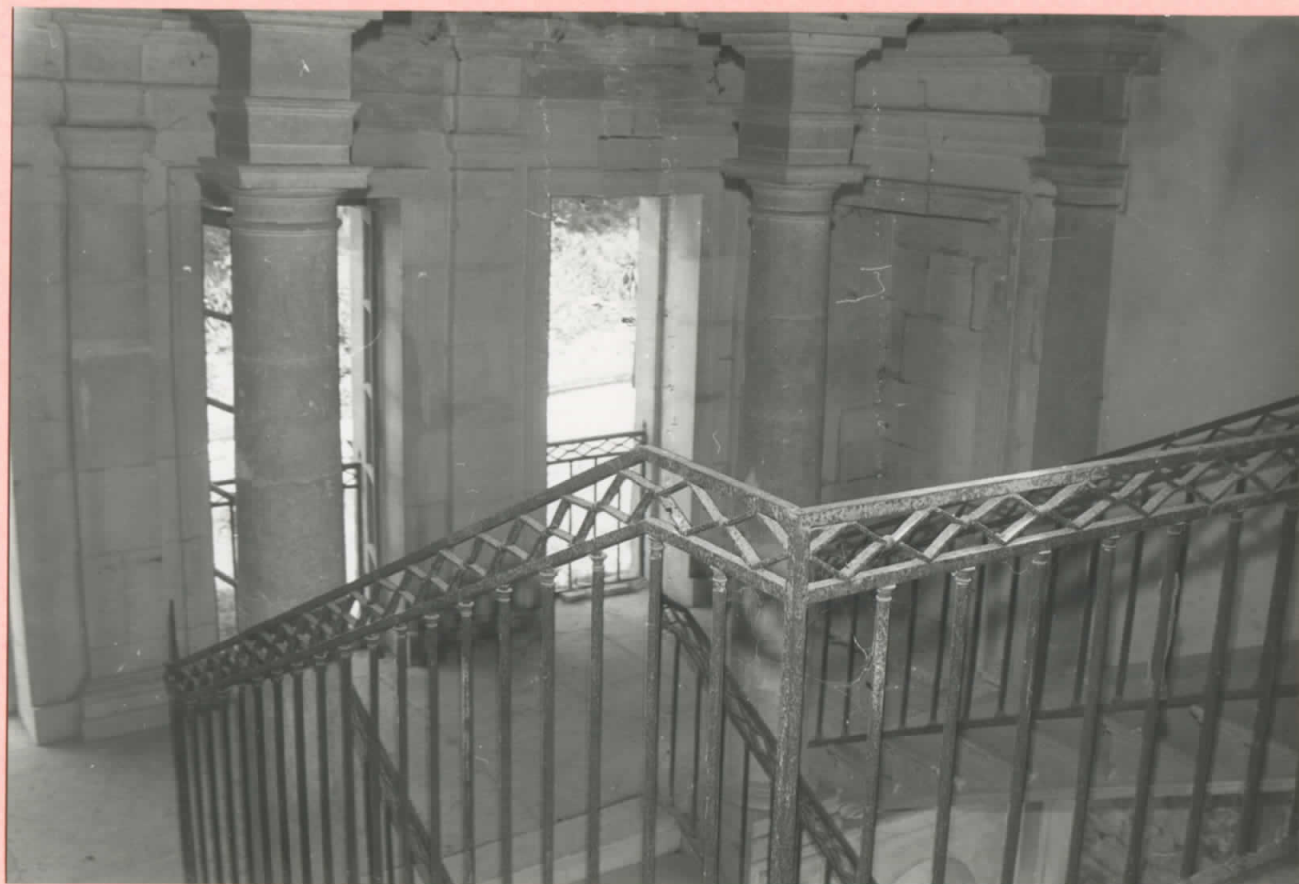
Rampe en fer forgé, ornée de losanges, del'escalier intérieur du châtea
