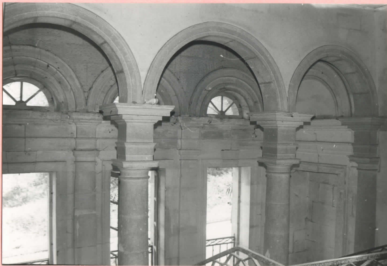
Escalier intérieur du château
