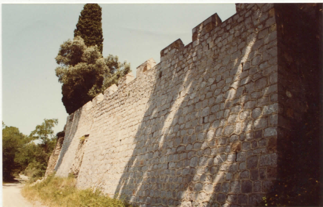
10 - Mur d'enceinte Sud
