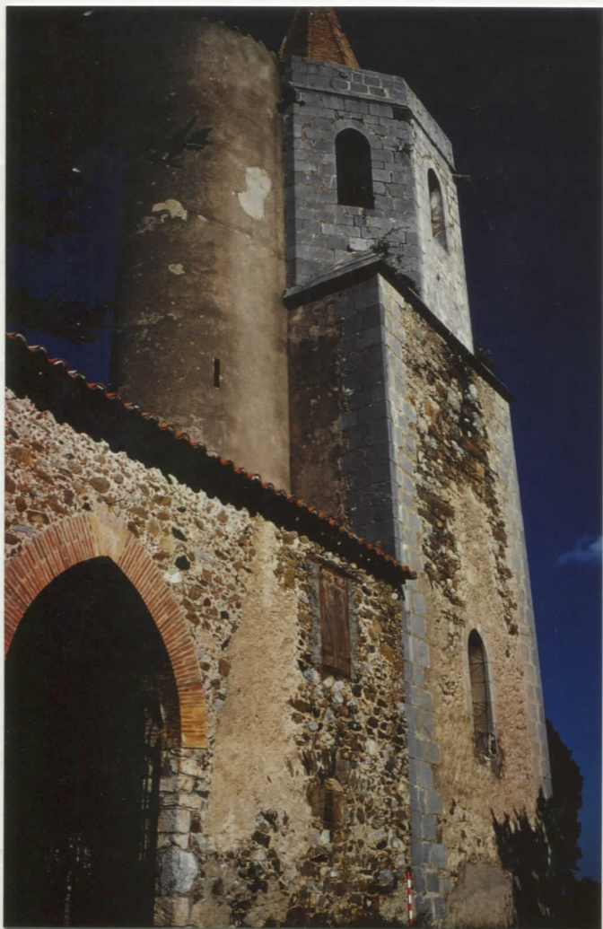
Escalier et clocher
