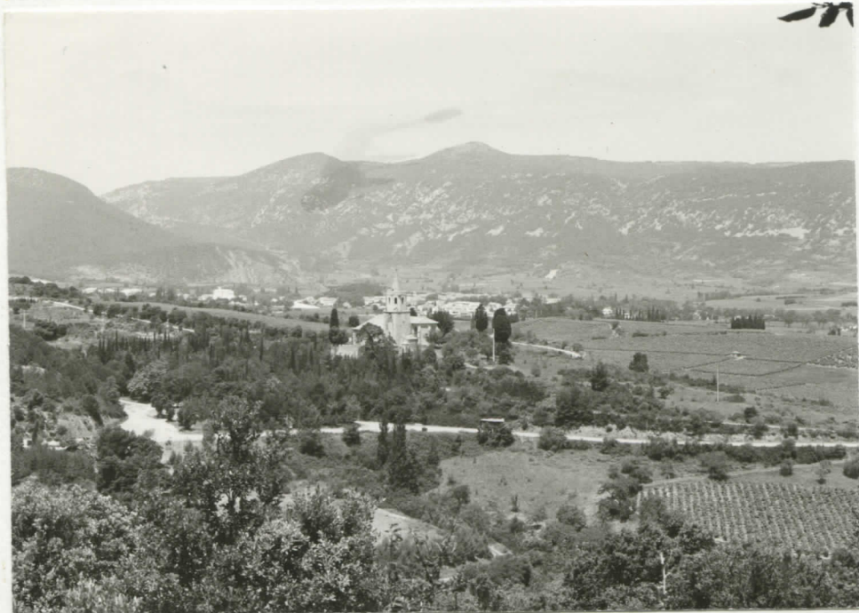
1 - Vue générale du site prise du Sud-Est
