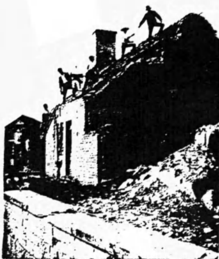
96 Camille Coppenet 96 Léon Arsène Emile Arsène Démolition de la maison de la "Bouvière" Villars, 12 Sept. 96.
