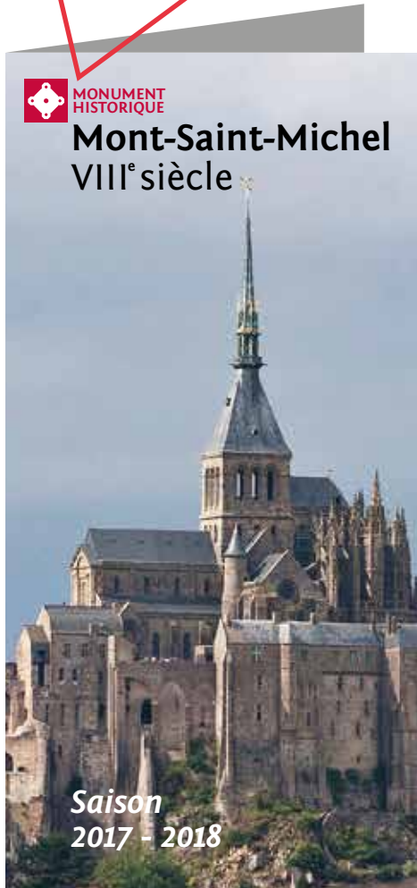
Application sur couverture de dépliant
