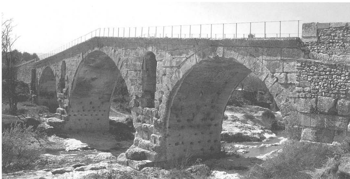
Fig. 97 — APT / BONNIEUX, Pont Julien. Mur de tête amont du pont (Cl. J.-M. Mignon).
