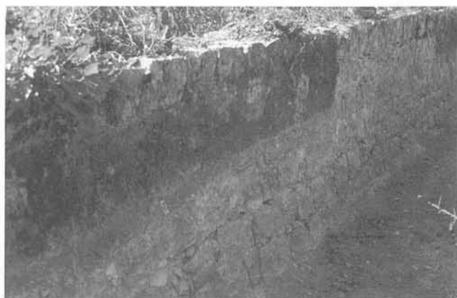
Fig. 70 — MONTAUROUX, Aqueduc de Fondurane. Partie médiévale présumée du canal.
