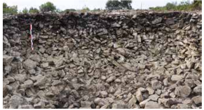
Fig. 4 : sondage 1, section sud – le remblai de nivellement de la terrasse (cliché : M. Scrinzi).
