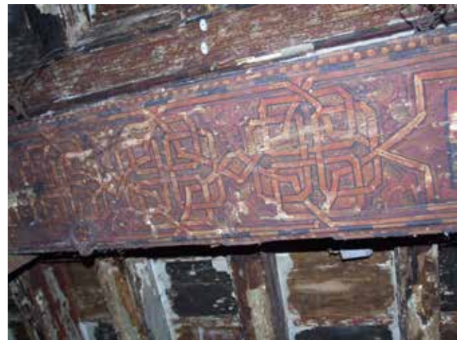
Fig. 4 : Montpellier 1 rue Collot. Détail d'un plafond de style mudéjar du XIII e siècle (cliché SRA, J.-L. Vayssettes).
