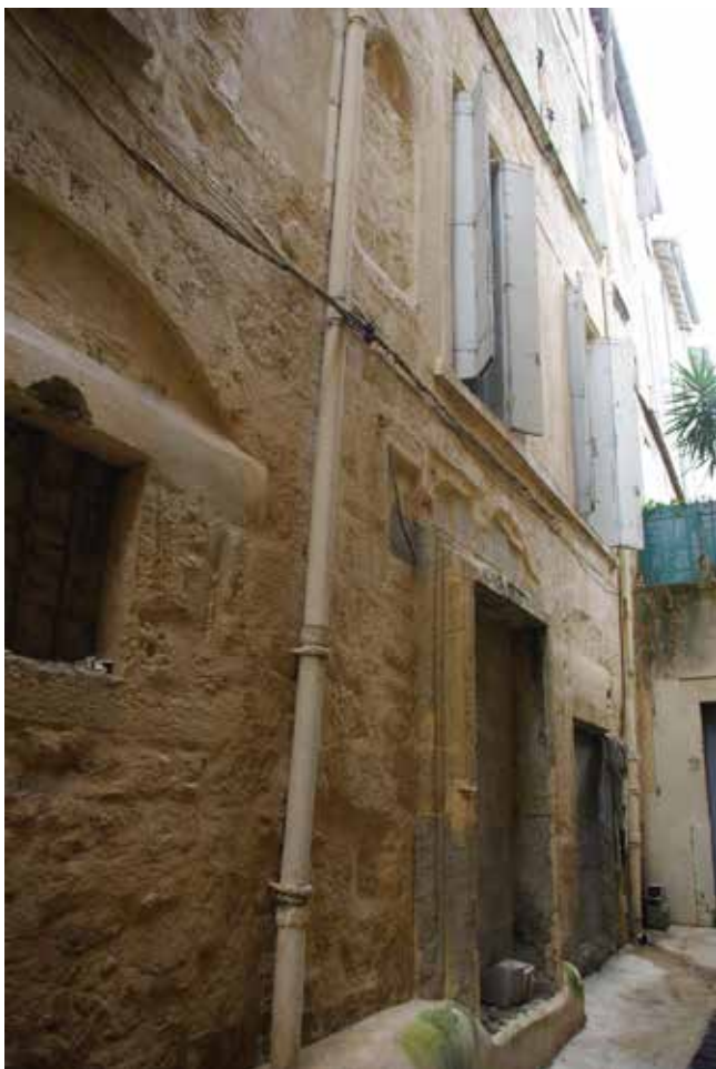
Fig. 1 : La façade nord-ouest de la maison vue depuis l'impasse de Ratte (Benjamin Michaudel)
