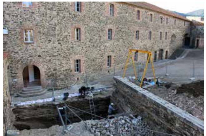
Fig. 4 : fouille du fossé médiéval. Au XVI e siècle, ce fossé est traversé par un passage ou pont mort, constitué de deux murs parallèles supportant un tablier en bois (cl. PAD, CD66).
