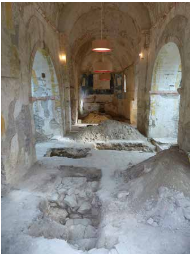
Fig 1 : Vue des tranchées réalisées à l'intérieur de l'église. Dans le sondage au premier plan, les fondations du pignon ouest de l'édifice roman et les couvertures des tombes médiévales. Cliché M. Ott, Inrap
