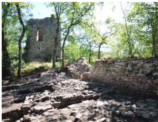
Fig 1 : façade ouest de la tour (Cliché J.-P. Cazes, 2016).
