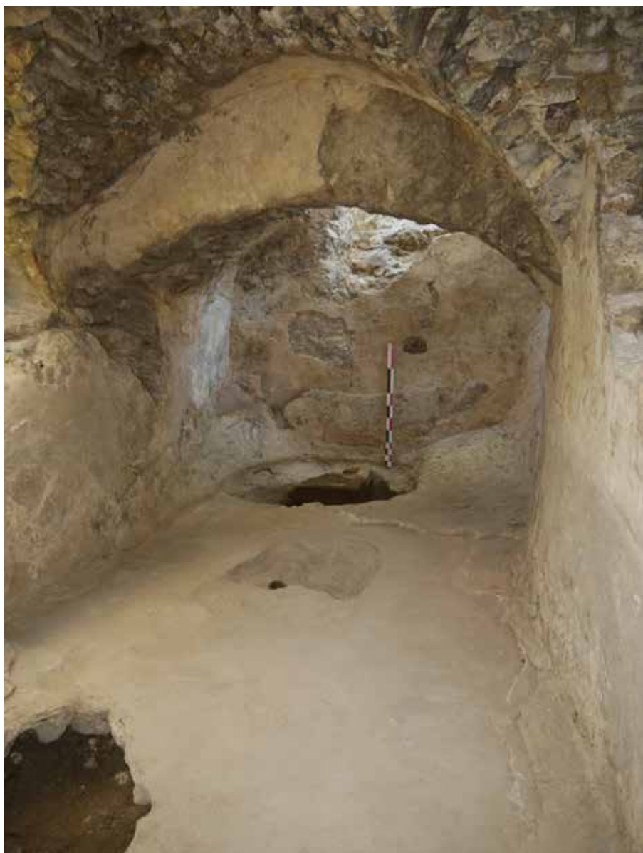
Fig. 1 : vue interne de la citerne.
