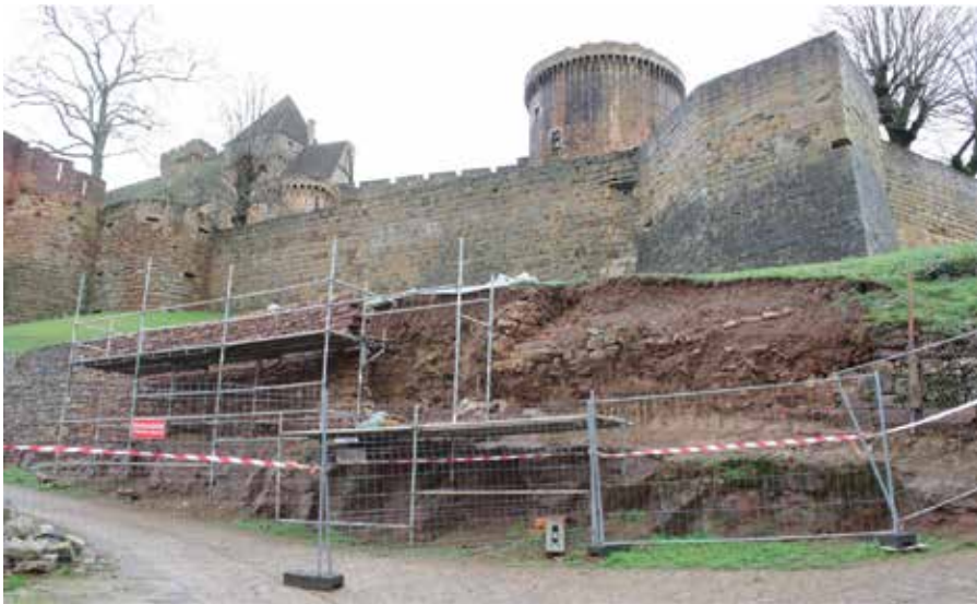
Fig 3 : vue générale (depuis l'est) de la brèche sud du mur de « fausse braie », et de la coupe du terre-plein (© Fr. Chaléat).
