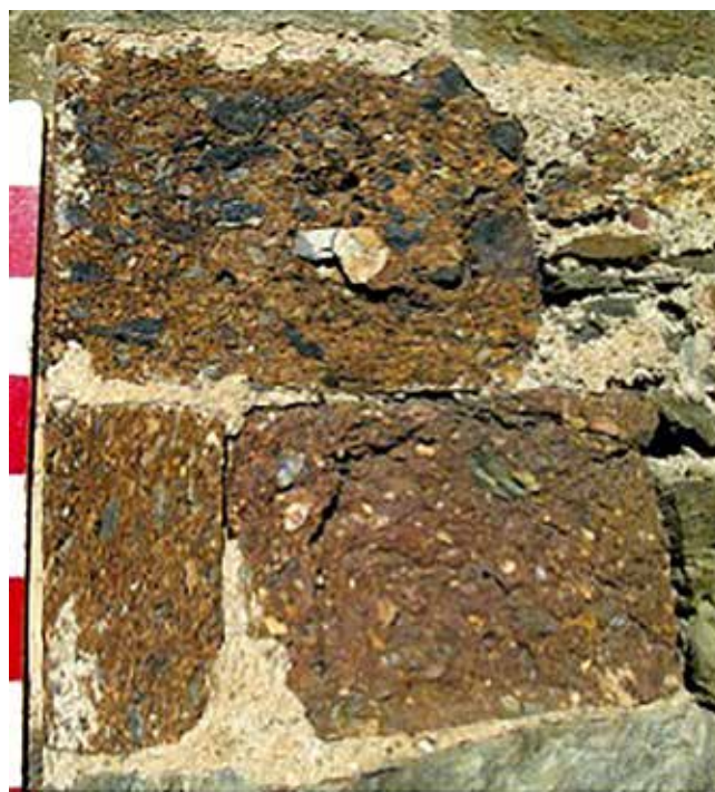
Fig. 2 : aspect typique de la brèche schisteuse à ciment siliceux et ferrugineux rouge utilisées au XI e s. dans le monastère de Sant Quirze de Colera (© C. Respaut).
