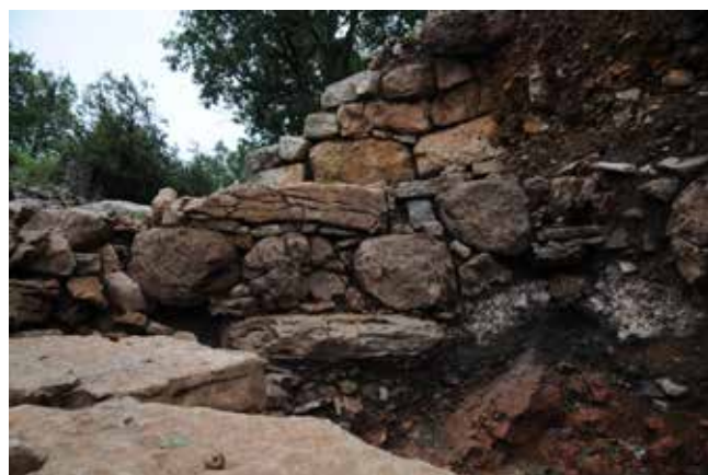
Figure 2 : Vue du parement extérieur du nouveau rempart.
