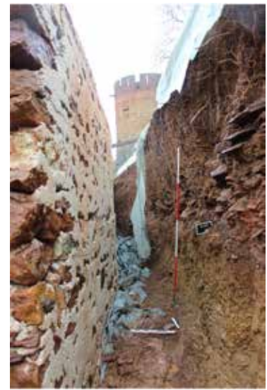
Fig 4 : vue générale (depuis le nord) de la partie de la coupe du terre-plein comprise derrière le mur de soutènement subsistant.
