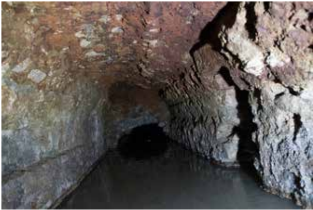
Fig 2 : chambre de visite vue vers le nord
