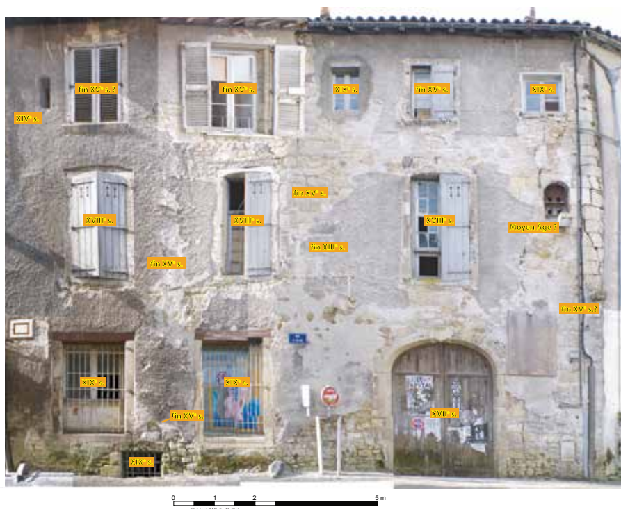
Fig. 2 : Villefranche-de-Rouergue, Place Bernard Lhez. Les différents aménagements repérés sur la façade nord des corps de bâtiments central et oriental de l'immeuble Marty nasses (Fr. Chaléat)
