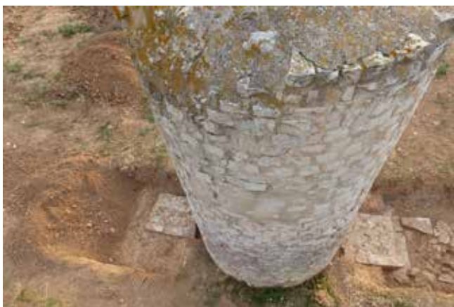
Fig. 2 : Massifs d'ancrage de la conduite forcée en plomb au pied de la pile P4, au niveau du « geniculus ».
