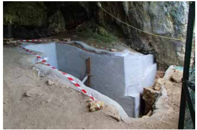
Grotte-Abri de Peyrazet : vue du muret de soutènement des coupes rempli de billes d'argile
