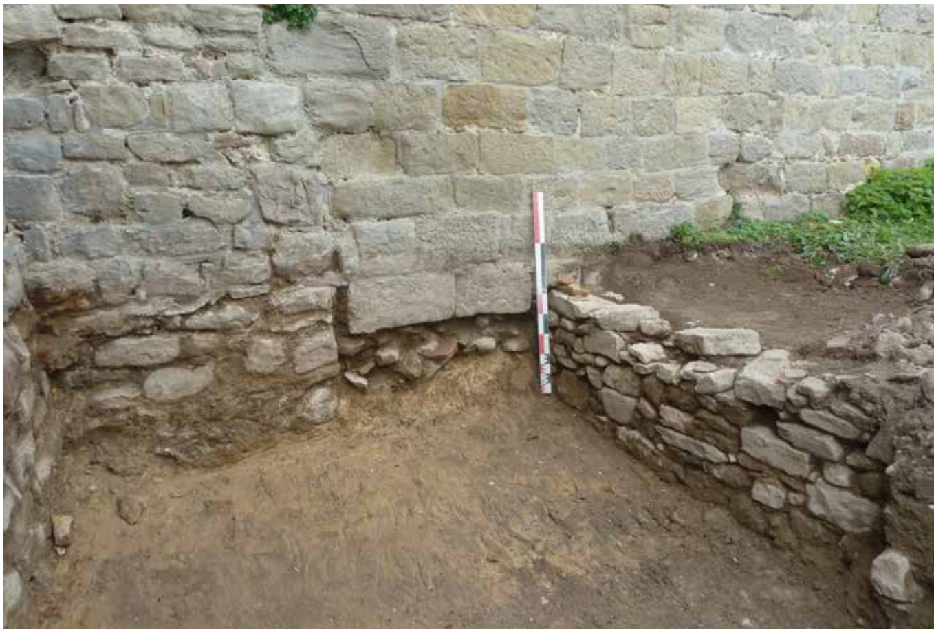
Fig. 1 : Reprises en sous-œuvre et muret près de la tour T23.
