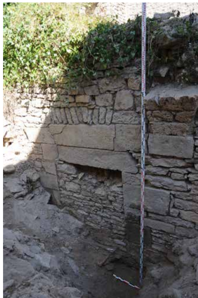
Fig. : Sévérac-d'Aveyron, Château. Cheminée et départ de voûte mis au jour dans la pièce ouest (G. Malige).
