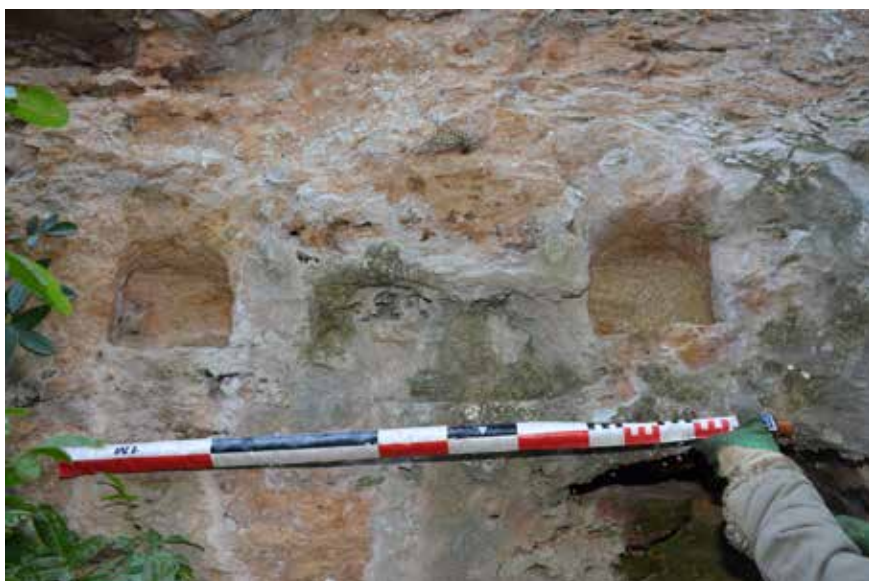
Penne, Les Battuts. Trous de solivages, partie inférieure.
