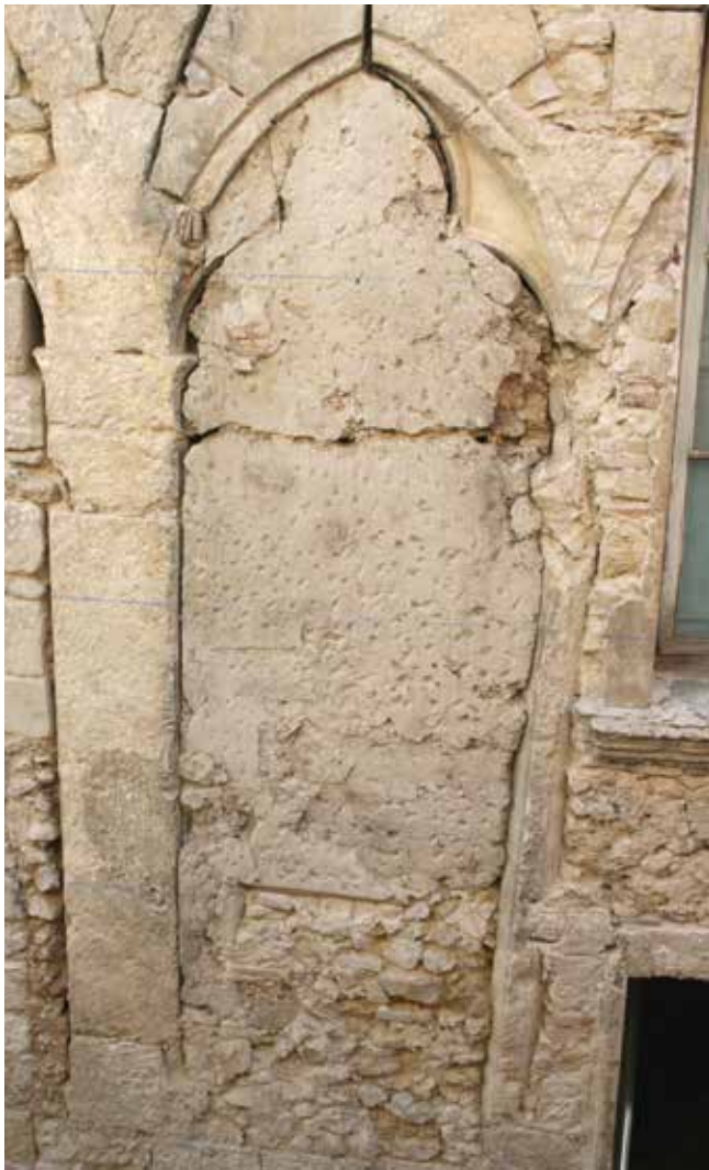
Fig. 1 : grande baie BE23. Vue générale d'une des baies jumelles conservée (lancette en arc brisé en tas-de-charge à réseau d'intrados trilobé ; milieu XIII e siècle). Son bouchage en terre est intervenu à l'époque moderne (XVII e siècle). Photo : F. Loppe, 2015.
