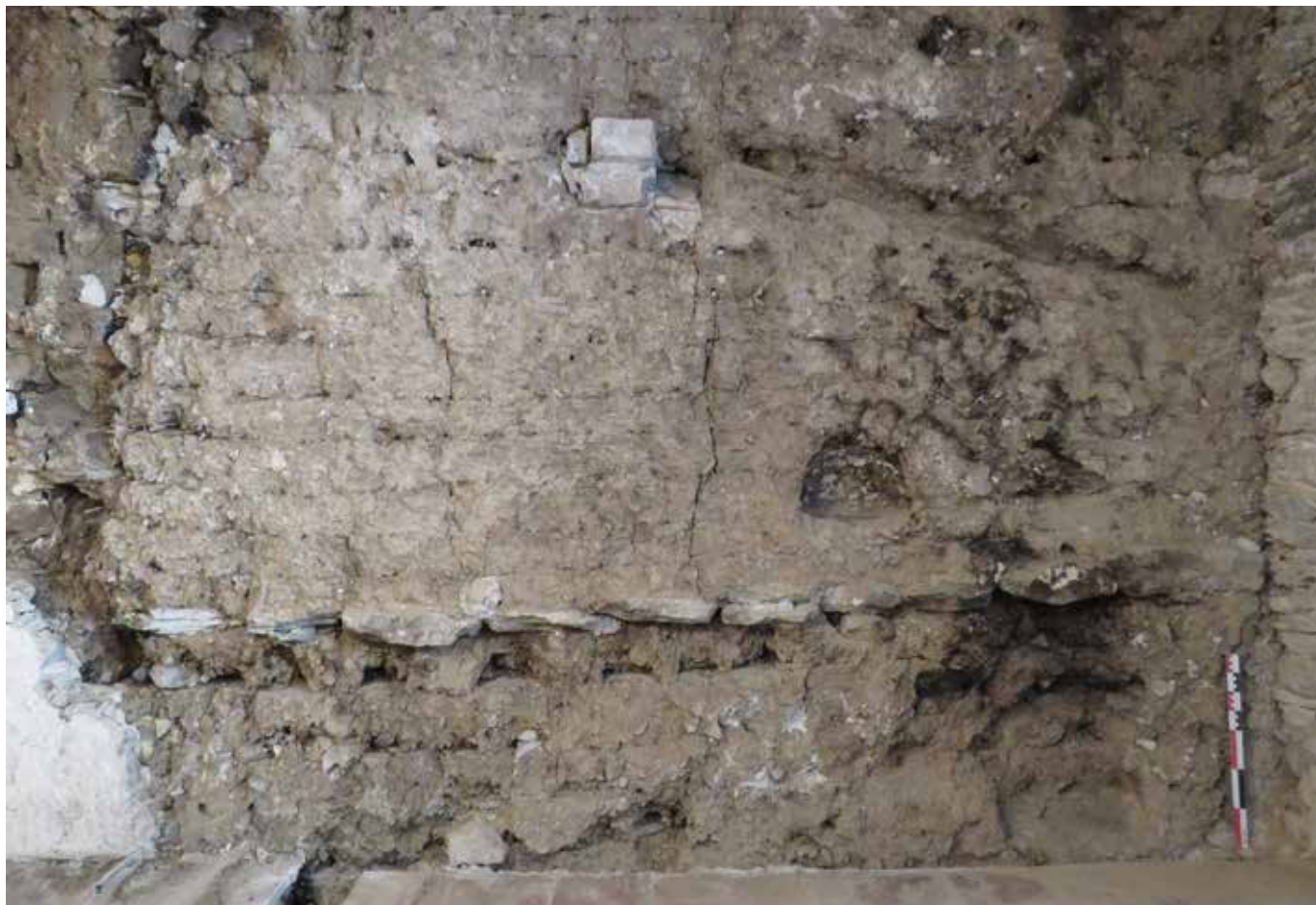
Fig. 2 : exemple d'élévation en bauge sur lit de bruyère (cliché E. Leal/Inrap).
