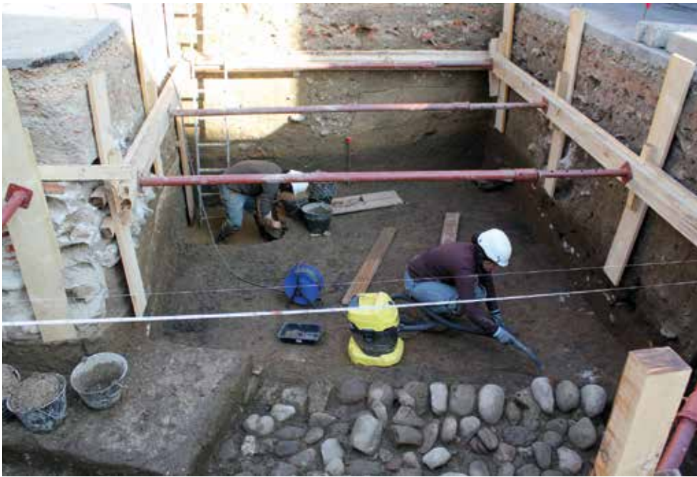
Fig. 1 : vue générale de la fouille rendu complexe par la mise en sécurité des parois (O. Passarius)
