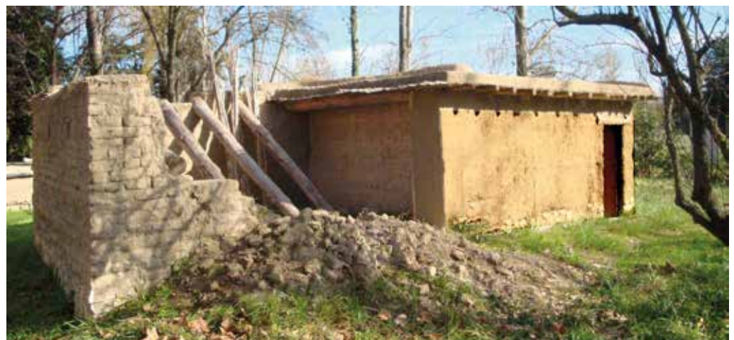
Fig. 3 : présentation du bâtiment en brique crue avec débord sur le mur gouttereau et destruction de la toiture et de la façade d'une pièce (clichés J.-Cl. Roux).
