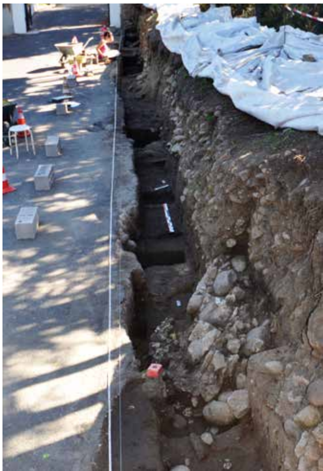
Fig. 1 : vue générale de la fouille après démontage du mur moderne. Au premier plan, le massif de maçonnerie antique basculé à 70°.
