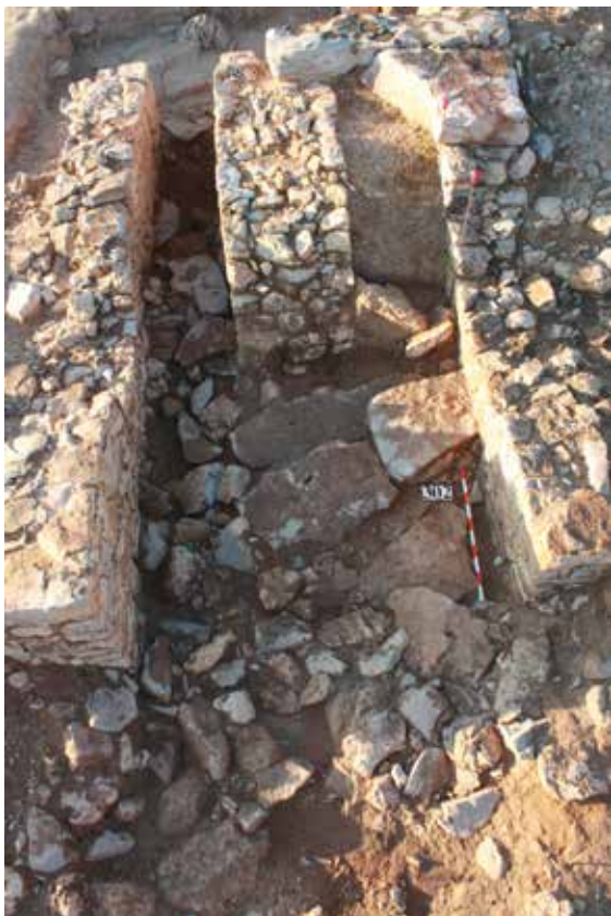
Fig. 3 : détail du ponceau en cours de démontage (louri Bermond).
