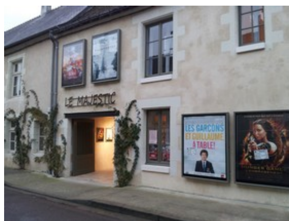
Le Majestic à Richelieu (Indre-et-Loire). Avant et après travaux.
