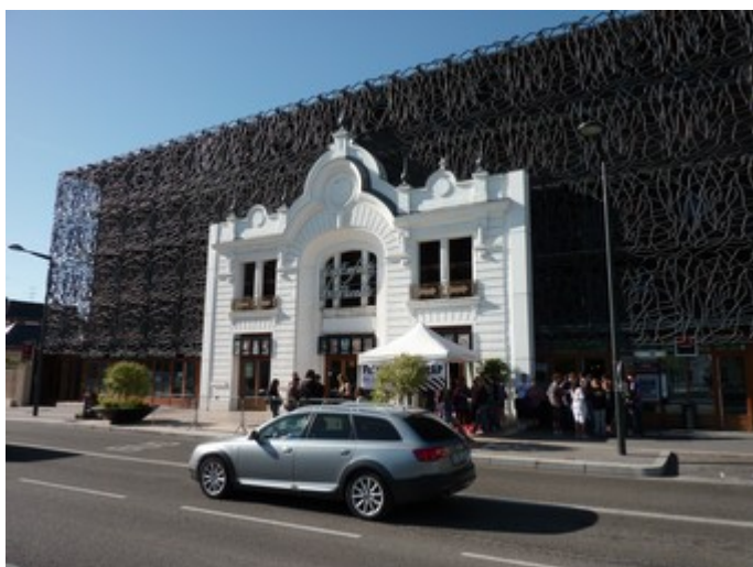
Les Enfants du Paradis, Chartres (Eure-et-Loir). L'armature métallique qui encadre la façade d'origine est l'oeuvre de l'architecte contemporain Rudy Ricciotti (né en 1952).
