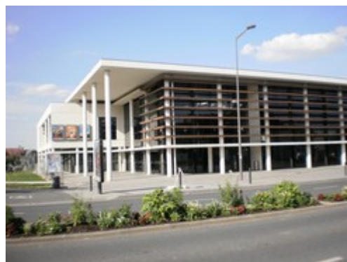
Les Elysées, Issoudun (Indre) – 3 salles. Ouvert en 2004. Classé « Art et Essai ».
