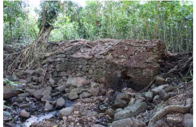
Figure 3 Le barrage poids, cliché N. Cazelles 2014
