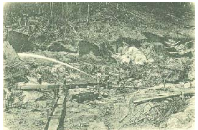
Figure 21 Chantier éluvionnaire avec attaque à la lance monitor (carte postale ancienne, Guyana)
