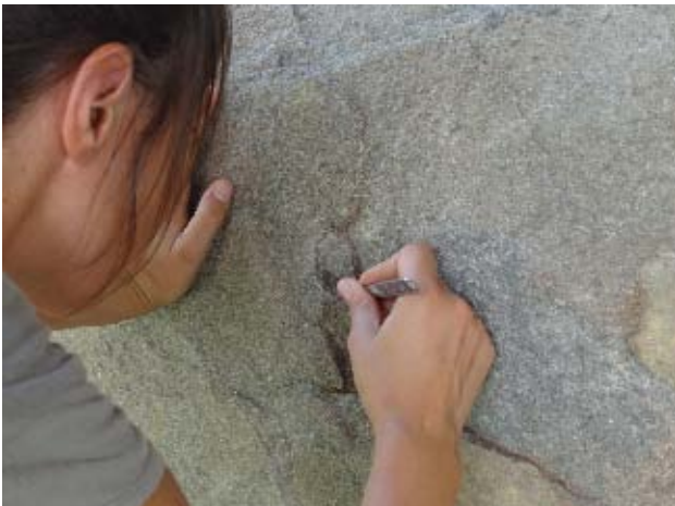
Figure 6 Pose de mortier par la restauratrice afin de consolider la roche – novembre 2014
