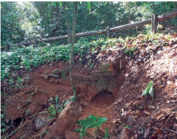
Figure 4 Galerie voûtée traversant la voie d'accès (aqueduc?)
