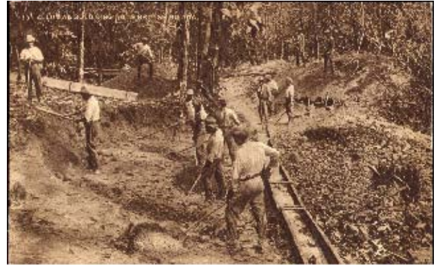
Figure 18 Chantier linéaire (ancienne carte postale, Guyana)
