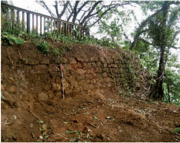
Figure 3 Vue du mur de terrasse au sud-ouest
