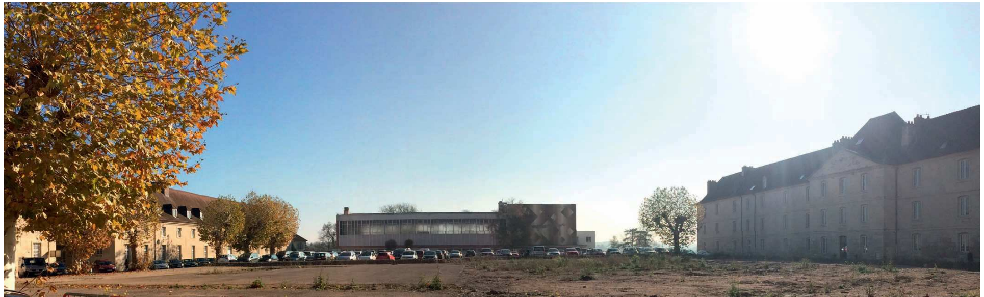
VUE LOINTAINE Place Précipiano, bâtiment existant partiellement démoli (élévation)
