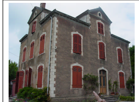
Volet sur une villa des ingénieurs
