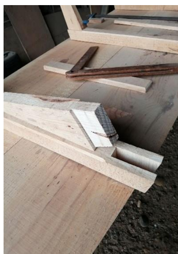
Ill. 23. Construction d'un couralin, atelier de Jean-Jacques Lahouze, avril 2020. © Florence Duhâa, 2020.
